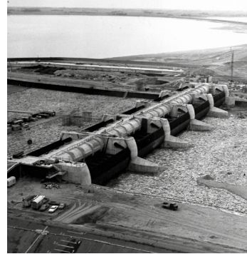
Das Eidersperrwerk ist eines der größten Küstenschutzbauwerke Europas Foto: WSA Tönning
